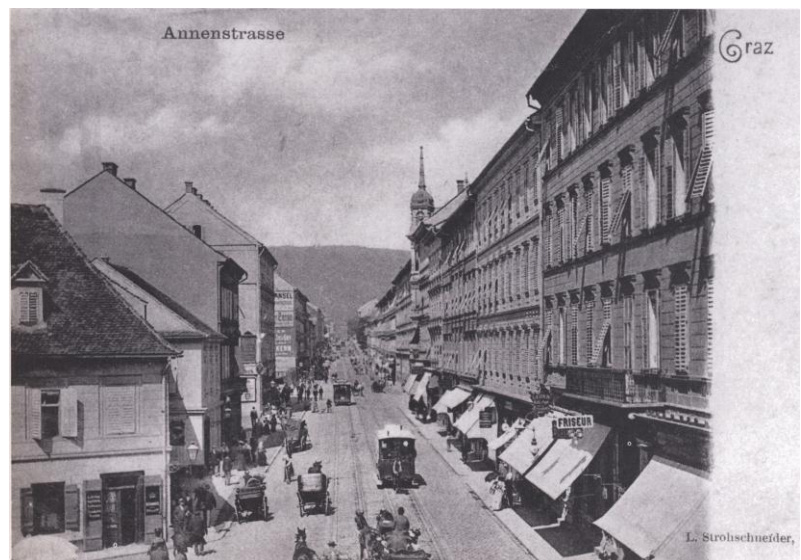
ANNENSTRASSE VON OSTEN, L. Strohschneider, 1899
