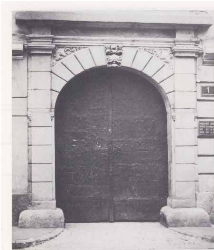
125. Dominikanergasse Nr. 1, ehem. Palais Gleispach, Hauptportal
