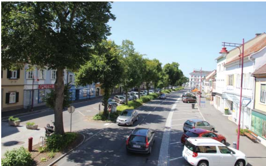
Hauptplatz, Blick nach Westen, Bestand 2017
