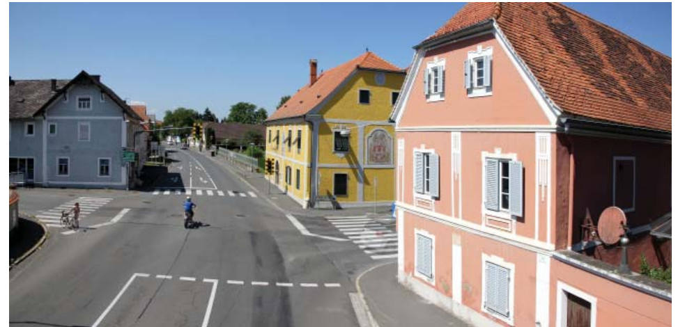
Kreuzung Grazer Straße-Eichfelder Straße, Blick nach Westen, rechts Haus Grazer Straße Nr. 18: Überall sind die Gehsteige zu schmal, zu viel Platz wird dem motorisierten Verkehr eingeräumt.
