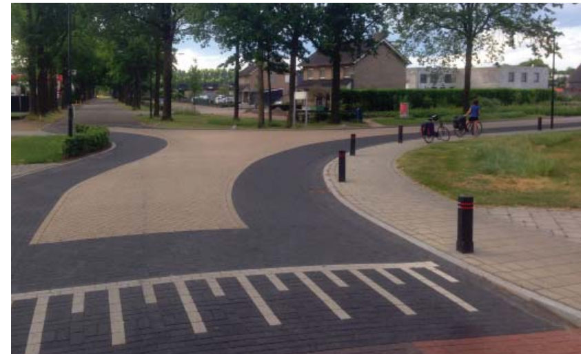
Holland - Gestaltung zur visuellen Einengung von Fahrbahn und Hervorheben von Querungen
