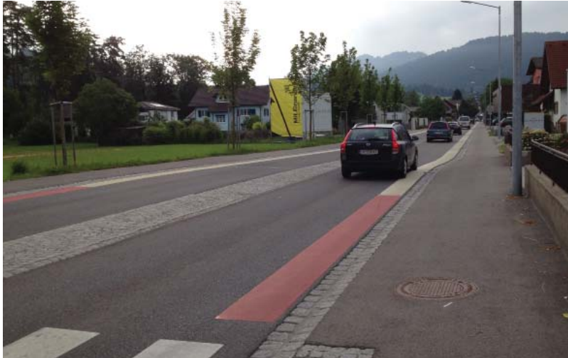
Ortsdurchfahrt Wolfurt (Vorarlberg) - Gestaltungselement: "eine 45 cm breite Straßenmarkierung" zur visuellen Einengung
