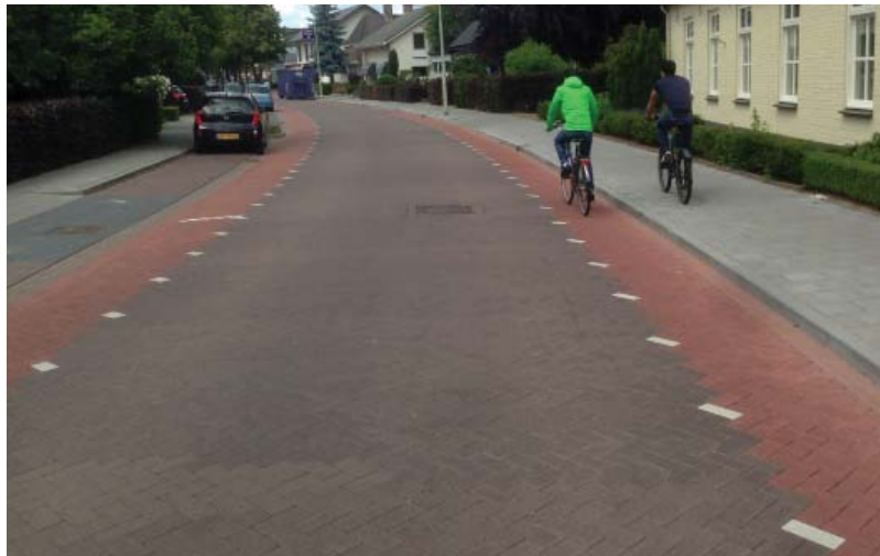
Holland - Gestaltungselement zur Temporeduktion von Autos - Streifen zur beliebigen Befahrbarkeit für Autos oder Zweiräder
