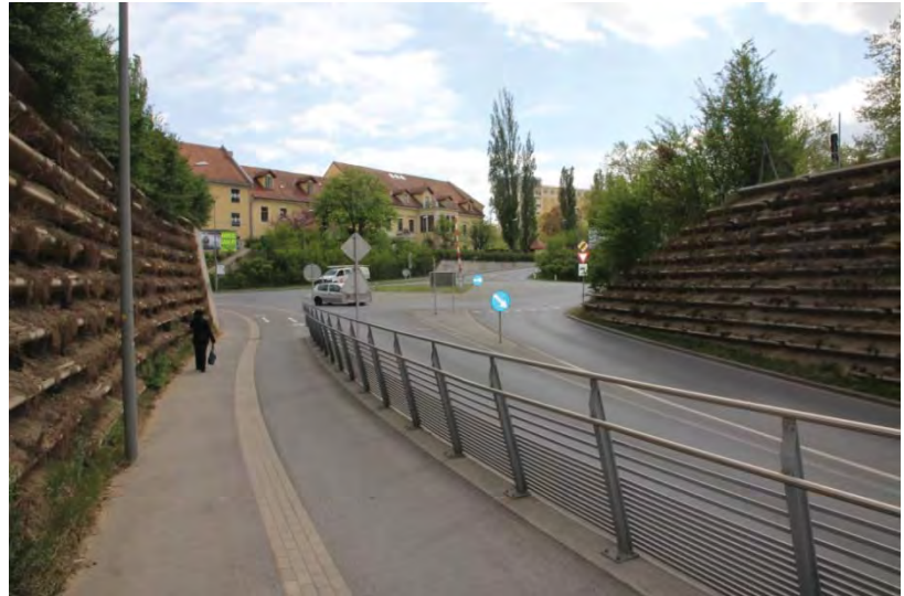
Bestand Kreisverkehr von der Unterführung in Richtung Süden
