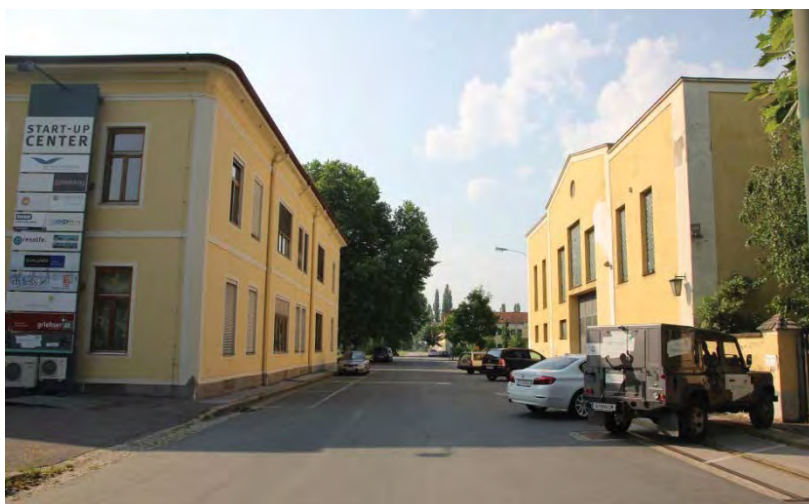
Die künftige ÖV-Achse an der engsten Stelle, Blick nach Süden ( links: Gebäude 13)
