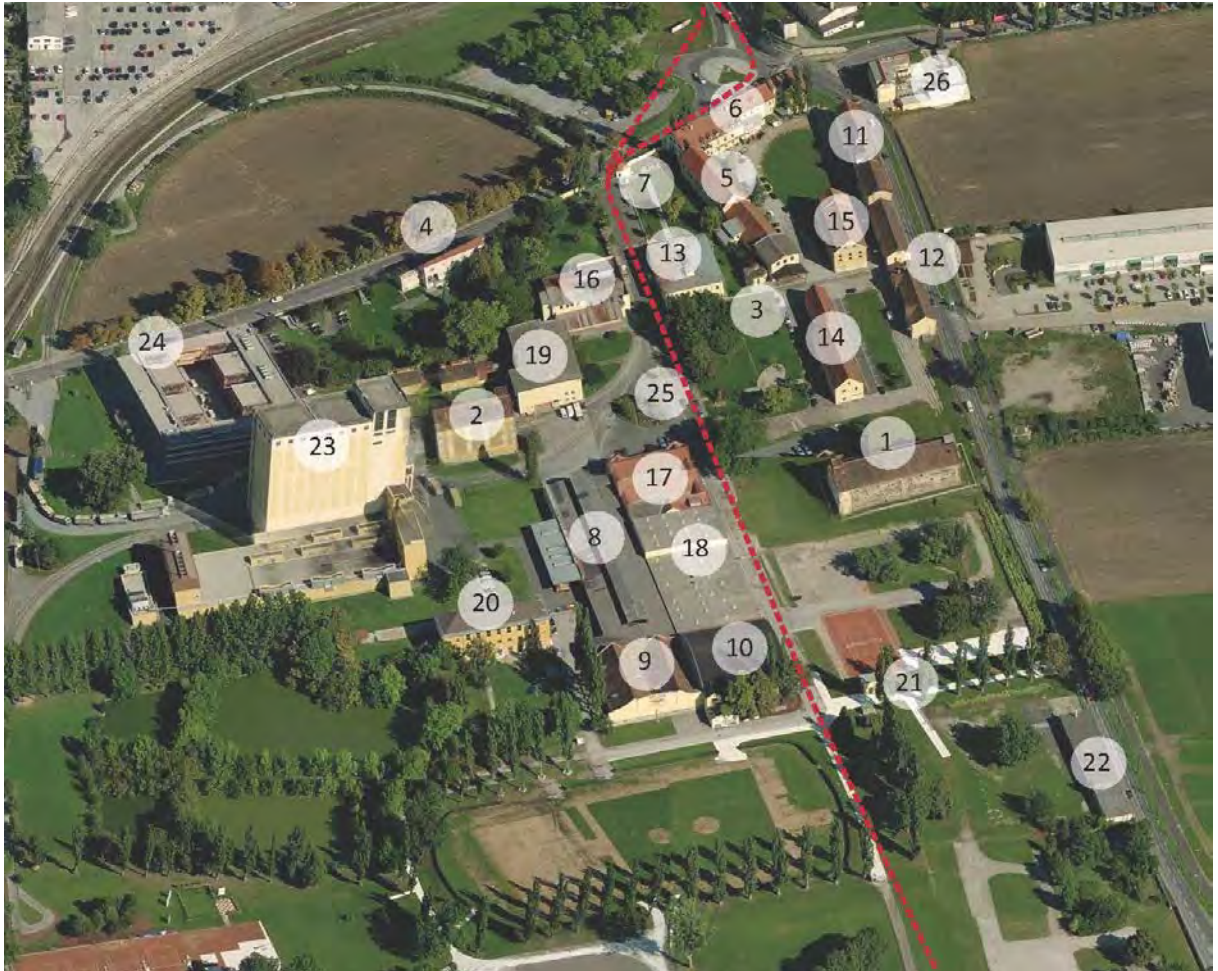
Aktueller Baubestand, Blick von Süden: Quelle: Bing Karten 2011
