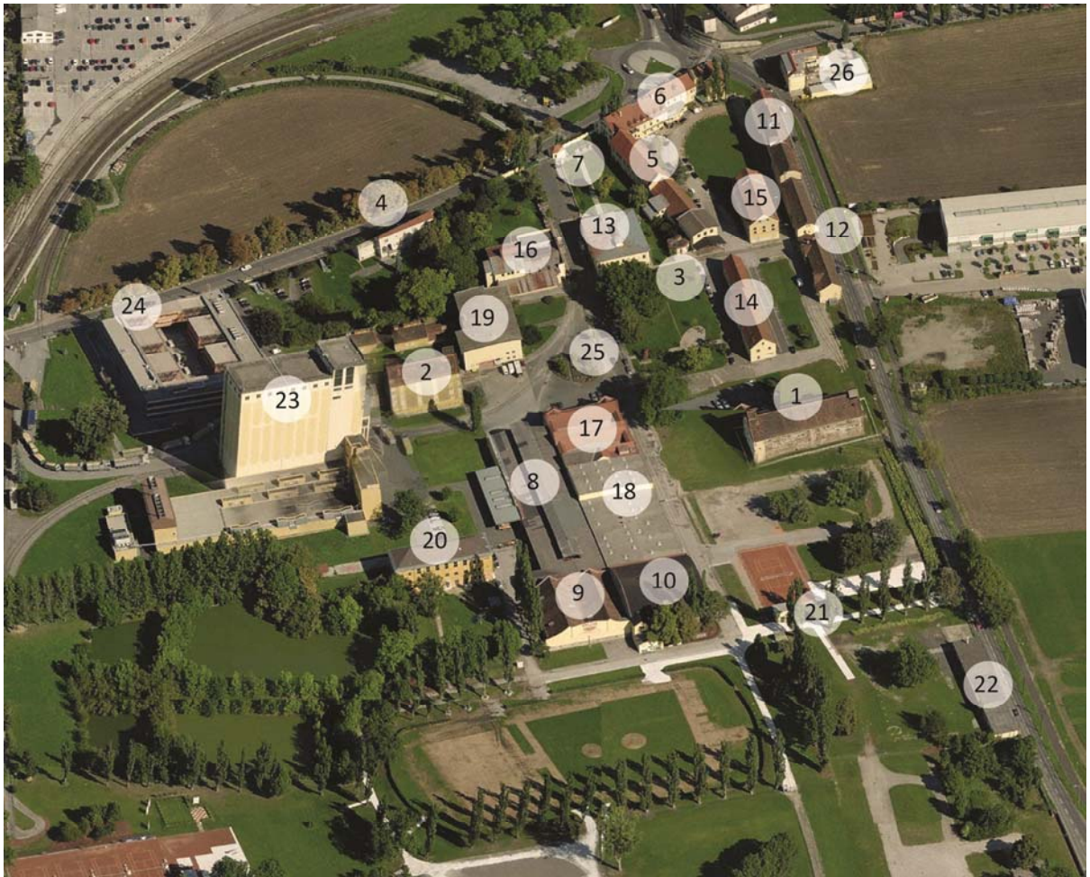
Aktueller Baubestand, Blick von Süden: Quelle: Bing Karten 2011
